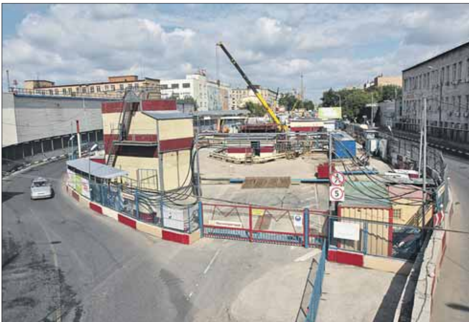
Строительство тоннеля на Огородном проезде
