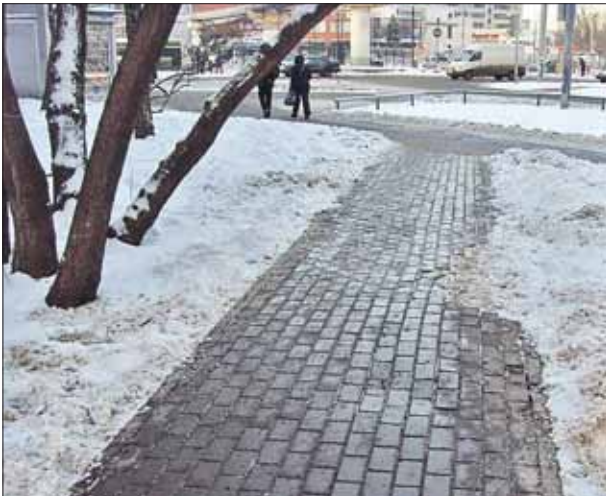
Окончательно восстановят покрытие из брусчатки после завершения работ
