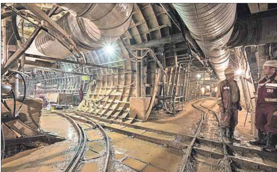
Тоннели прокладывают на глубине 63 метра
