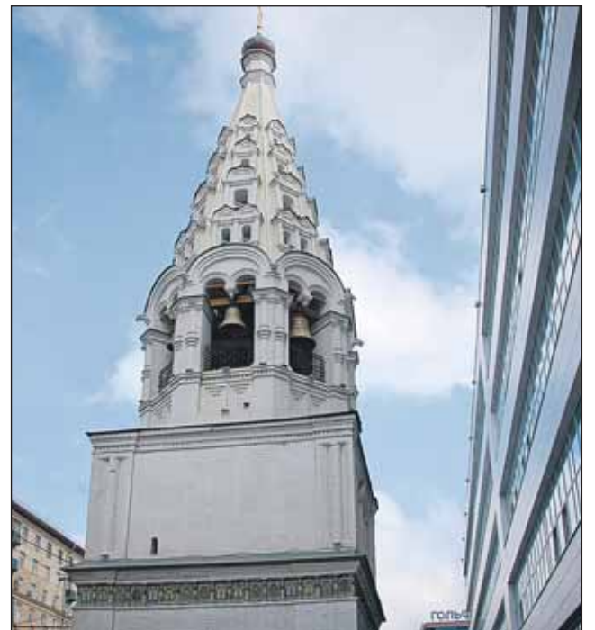
На колокольне восстановлен изразцовый фриз XVII века
