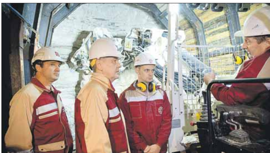
Ход работ на станции метро «Фонвизинская» проинспектировал врио мэра Москвы
